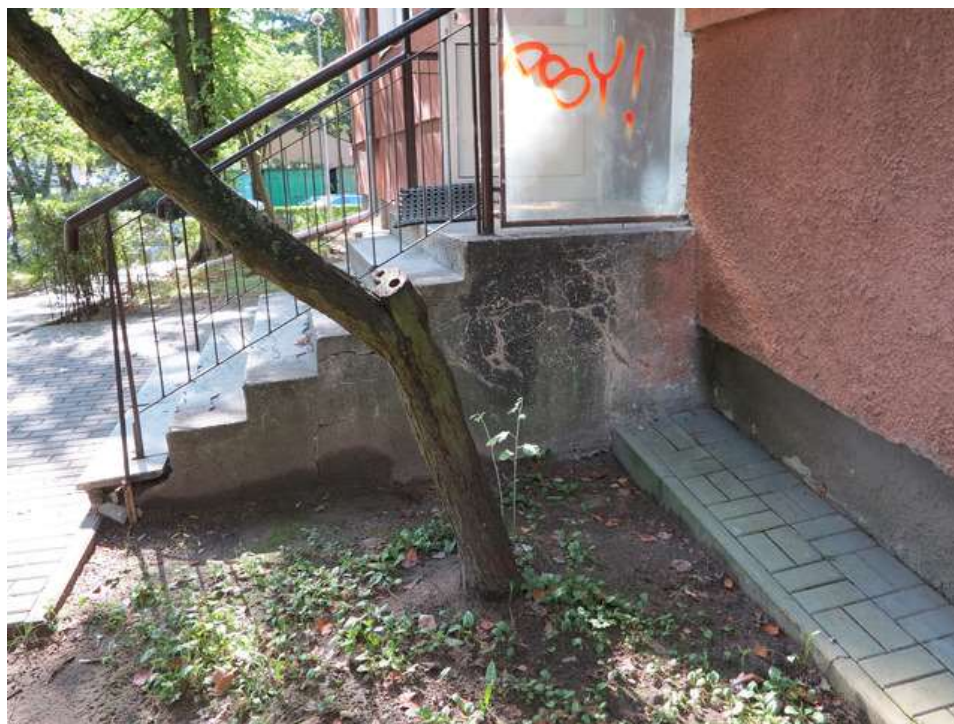
Fot. 3. Widok schodów z boku
