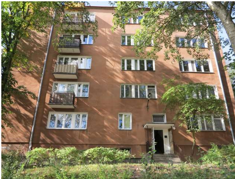
Fot.1 Widok ogólny budynku
