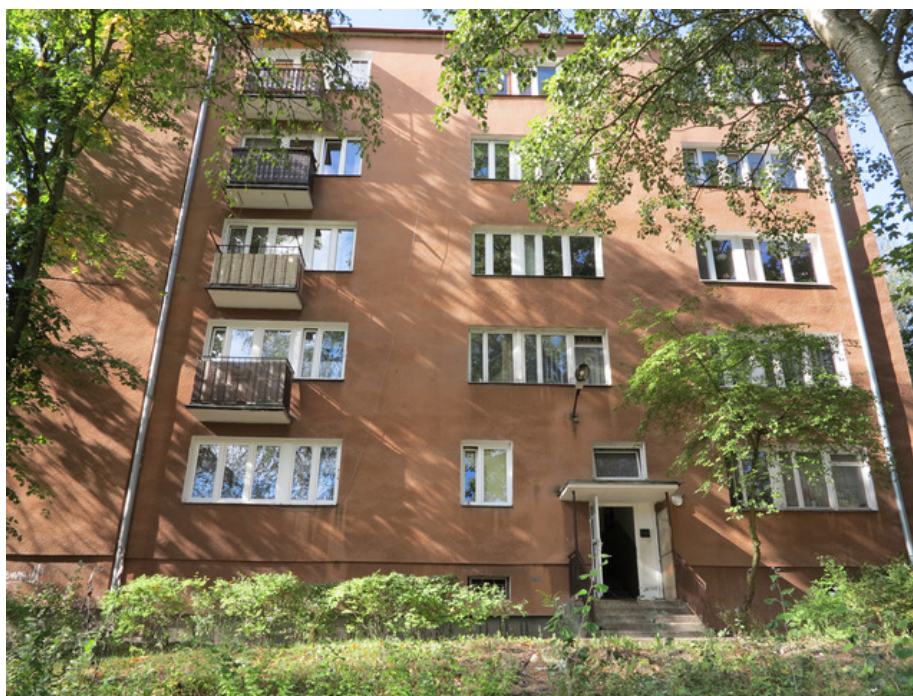
Fot.1 Widok ogólny budynku
