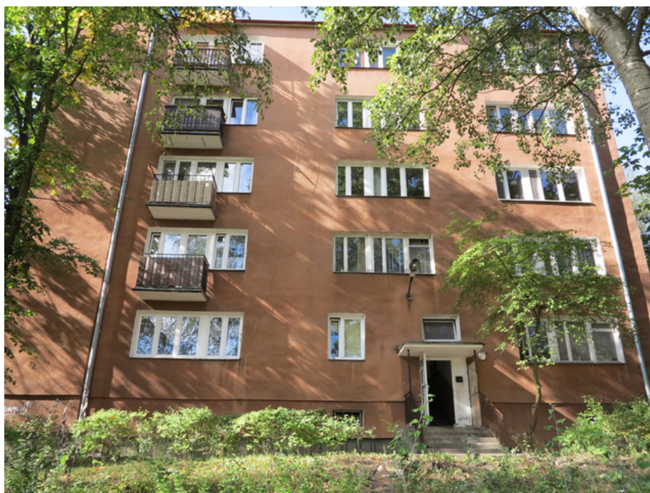
Fot.1 Widok ogólny budynku
