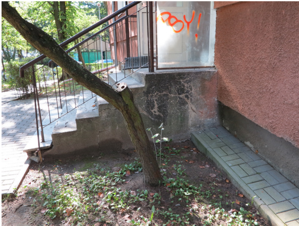
Fot. 3. Widok schodów z boku
