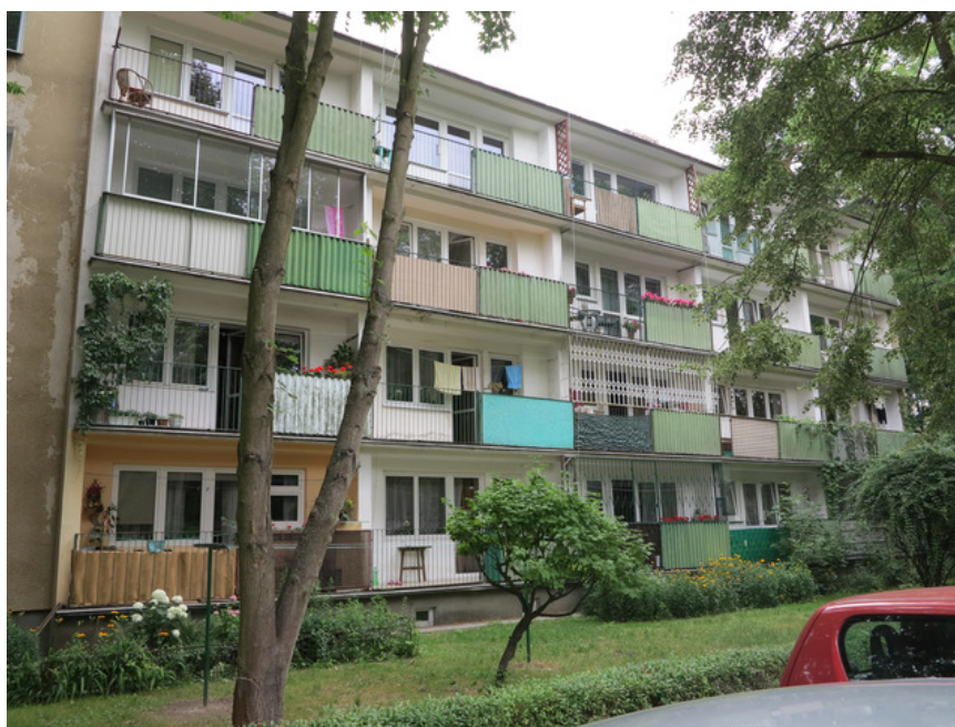
Fot. 1: Stan istniejący – Elewacji południowo - wschodnia
