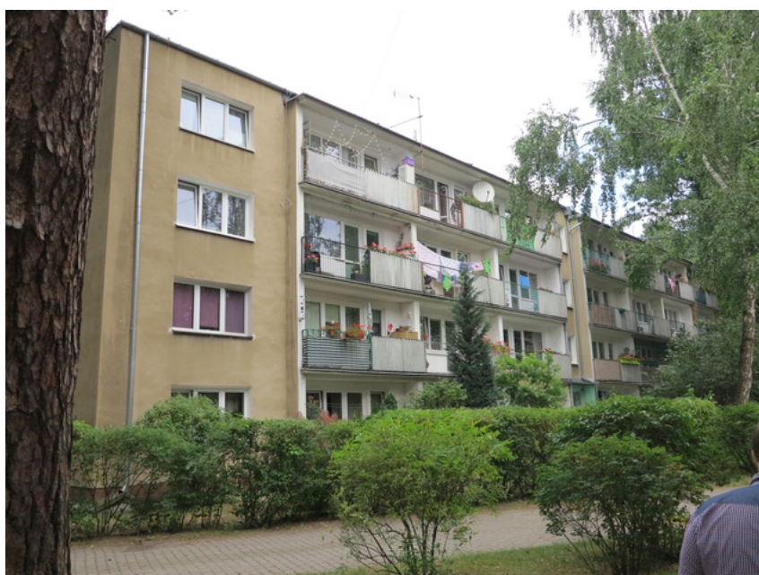
Fot. 1: Stan istniejący – Elewacji południowo - wschodnia
